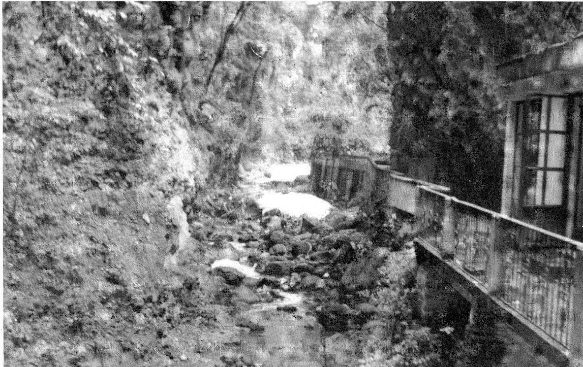
Foto 1. Entrada al Túnel con la vista del fondo y de las paredes de la barranca.
