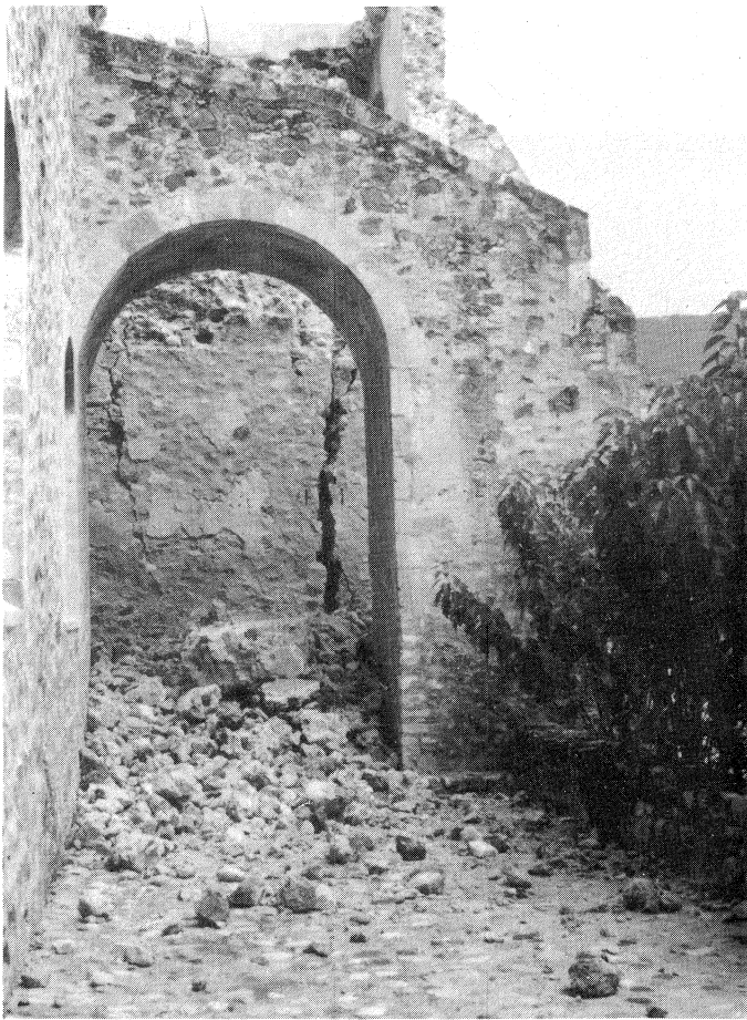
Fig. 13. Porción colapsada del convento el 19 de septiembre de 1992.
